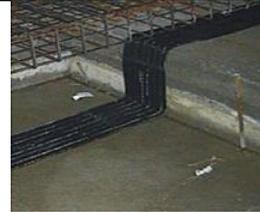
DIN18541 PVC-P-NBR en polymères mélangés ( Contrôle externe par MPA NRW)
